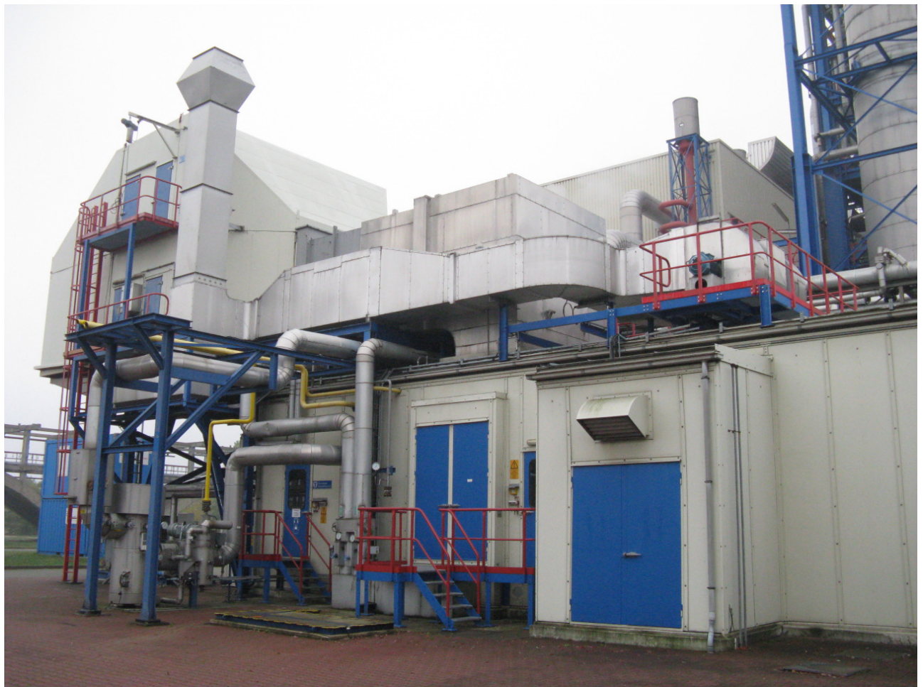
Bild 1: Gasturbinenumhausung
