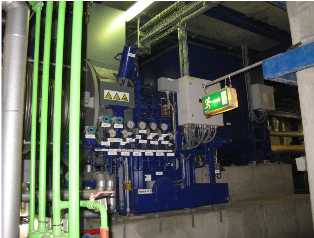
Bild 2: Dampfturbine mit Getriebe, Ölversorgung und Generator
